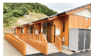
熊本豪雨では 612戸の 仮設住宅を建設
